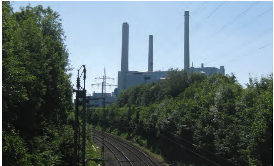
Die Landmarke des Heizkraftwerk Nords bietet vor Ort keinerlei Orientierung | Abb. 54
