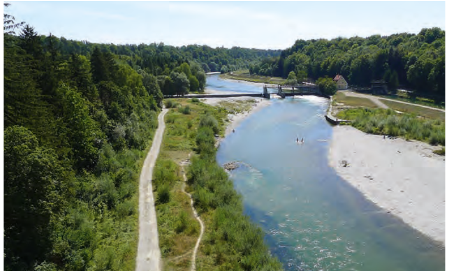
Isartal an der Großhesseloher Brücke | Abb. 10
